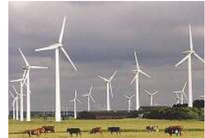
Wind farm 32 MW in Tejonero Andalucia DESARROLLOS EÓLICOS S.A.U.
