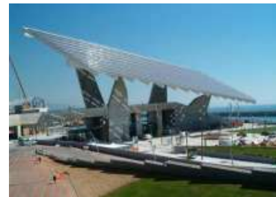
443 kW photovoltaic rooftop in Barcelona Cataluña INFRAESTRUCTURAS DEL LLEVANT
